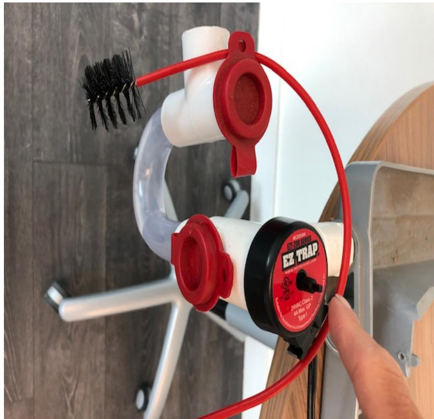
Quand la petite tige est abaissée c'est que tout est en marche. Si, il y avait un problème (drain bloqué) celle-ci se soulève et arrêtera votre système au complet. (Fournaise & thermopompe), afin d'éviter un dégât d'eau.
